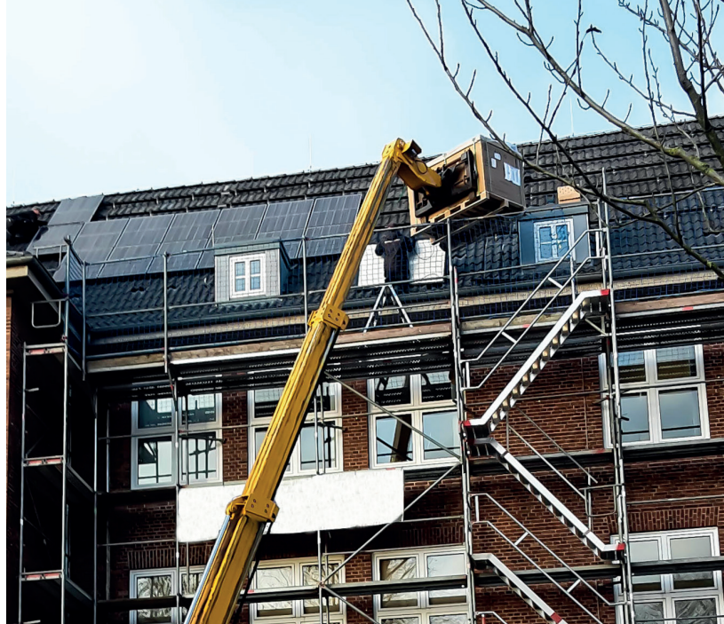
Solcellerne bliver sat op på bygningen.
